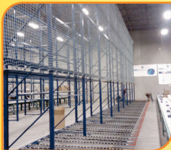
Dịch vụ bảo trì sửa chữa hệ thống máy móc nhà xưởng Maintenance and repair services of machinery factory system 機械工場システムのメンテナンスと修理サービス
